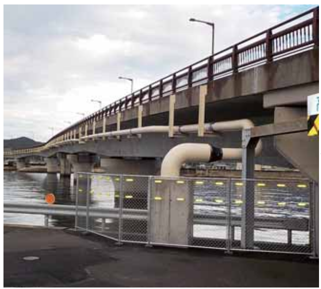
新居浜LNGでのガス管の添架も設計した
